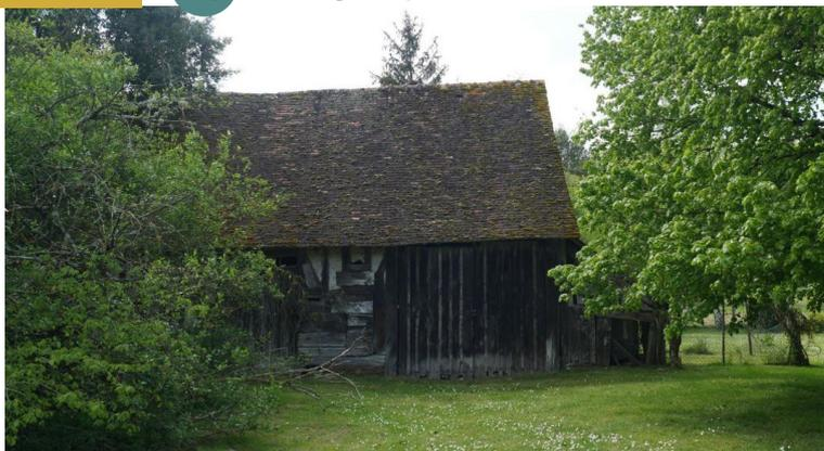
En faisant quelques pas à gauche sur la route de Romorantin, on remarque une ancienne grange, en renforcement et un peu dissimulée par la végétation. Elle révèle ses pans de bois hourdis de torchis.
