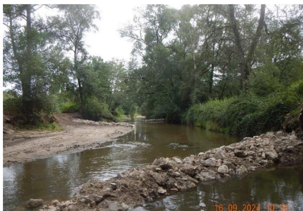
Le substrat des merlons n'étant pas suffisant pour mettre fin au dysfonctionnement présent, des matériaux supplémentaires sont apportés. Il s'agit de granulats alluvionnaires de 4 à 15 cm de diamètre disposés dans la rivière de manière à protéger et le fond le fond du lit. Des banquettes sont formées donnant une sinuosité du cours d'eau (cf schéma de principe)
