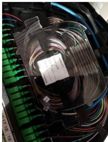
Le SMO réalisait des contrôles de qualité par mesures optiques de la liaison de collecte entre les NRO de Fréteval et Pezou. Ces mesures permettent d'identifier les éventuelles anomalies sur les 48 fibres optiques constituant la liaison.
